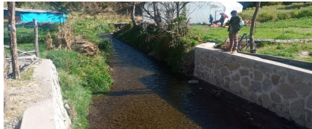
FOTO 03 Y 04: Fial del tramo de identificación de punto crítico del río CCAHUAYA, se aprecia cauce colmatado, taludes naturales y con presencia de defensas vivas el cual viene estrangulando alcauce del río Ccahuaya.
